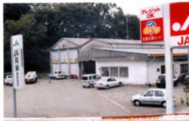
高森町草部地区にある「草部支所」
