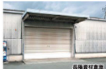
長陽資材倉庫
