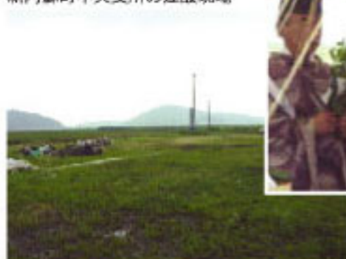
新阿蘇町中央支所の建設現場
