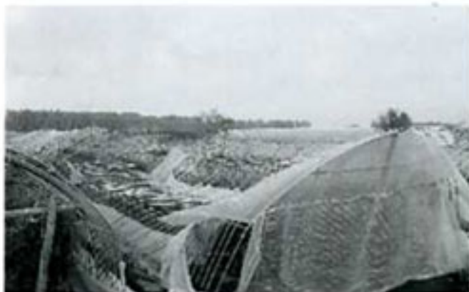
なぎ倒されたトマトハウス(18号・一の宮町)
