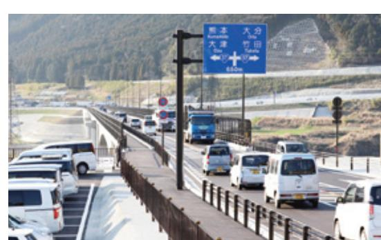
新橋は全長525m、旧橋の約600m下流に位置し熊本地震を教訓に大きな揺れの際、橋桁の落下などを防ぐため、橋の一部があえて壊れる損傷制御という工法が取られている。
